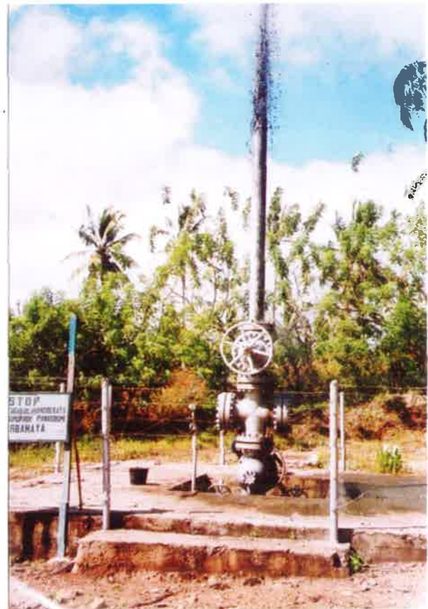
Gambar 4. Instalasi Sumur Eksplorasi AT-1 Kaoangan Panas Bumi Atadei, Lembata, NTT
