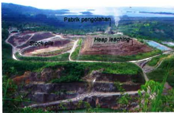
Gambar 1. Tambang Emas Mesel, Minahasa, Sulut pada tahun 2003, situasi menjelang penutupan tambang, mengolah sisa bijih yang tersimpan pada *stockpile* (Tain dkk., 2003)
