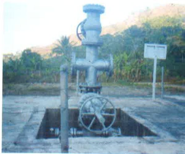
Gambar 7. Instalasi sumur Eksplorasi AT-2 Lapangan Panas Bumi Atadei, Kabupaten Lembata, NTT
