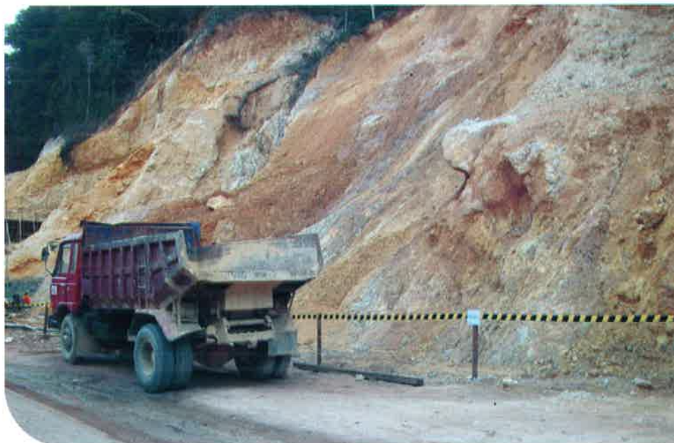
Gambar 6 : Pengupasan dinding batugamping di lokasi kelok sembilan, Sumatera Barat, dalam rangka pembuatan jalan alternatif
