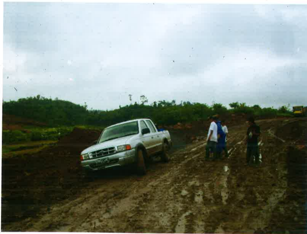
Kondisi jalan pada lingkungan penambangan batubara, Muara Bungo, Provinsi Jambi
