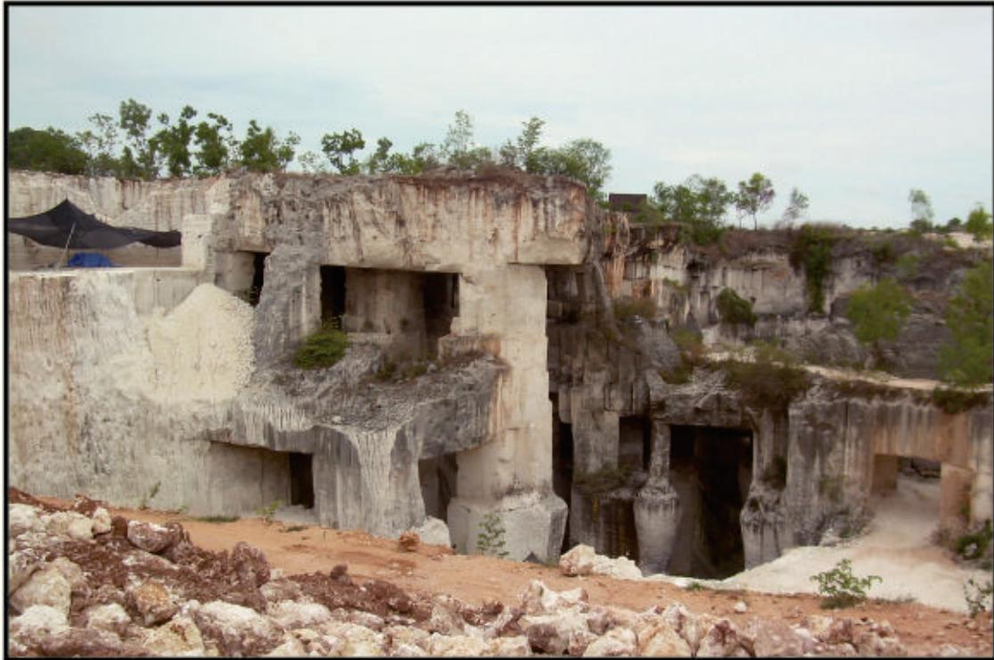
"Room and Pillar Mining Method" merupakan salah satu metoda canggih yang biasanya diterapkan dalam sistem penambangan bawah tanah. Ternyata metoda ini telah sejak lama digunakan pada "kumbung" atau penggalian dolomit secara tradisional untuk dijadikan pengganti batubata atau batu fondasi di sepanjang pantai utara Jawa Timur dan Pulau Madura. Lokasi foto di daerah Desa Sidokelar, Kecamatan Paciran, Kabupaten Lamongan, Provinsi Jawa Timur.
