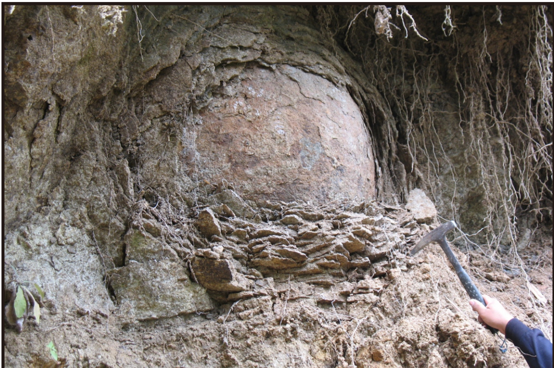
Perubahan dari dingin menjadi panas menyebabkan retak mendatar. Sebaliknya, dari panas menjadi dingin menyebabkan pembentukan retak-retak radial pada batuan. Pelapukan mengulit bawang terdapat pada Formasi Sekala di daerah Lembang Manggau, Kecamatan Makale, Kab. Tana Toraja, Sulawesi Selatan. (Irwan Muksin, 2012)
