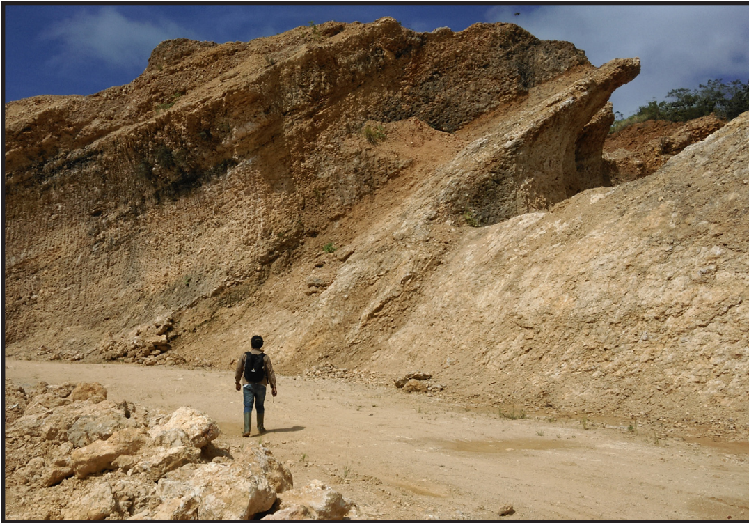
Batugamping pada Formasi Maluwi, dimanfaatkan sebagai bahan galian untuk pondasi jalan pada perkebunan sawit. (Dede Ibnu)
